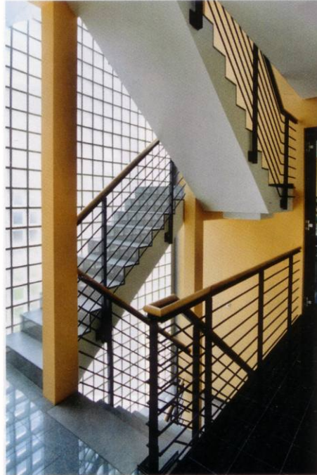
Das farblich harmonisch gestaltete Treppenhaus wird belichtet durch eine Glasbausteinwand.
