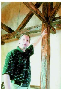
Architekt Erik Ressel weist auf ein Balkenkreuz, das einem Zimmer im Obergeschoss ein ganz besonderes Flair gibt.
