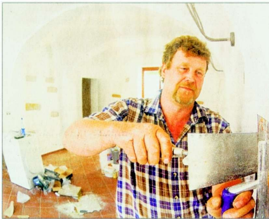
Handwerker Rainer Storch bei den letzten Innenarbeiten vor der Eröffnung.
